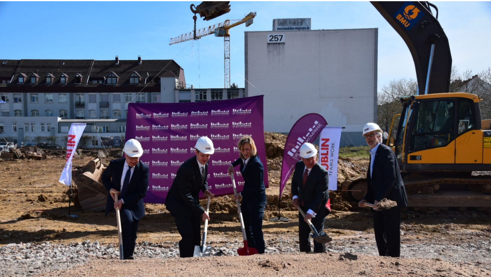
v.l.: Paul-Gerhard Weiß (Offenbachs Baustadtrat), Felix Schwenke (Oberbürgermeister), Iris Dilger (Wohnkompanie), Konstantin Westphal (NH) und Horst Schneider (Oberbürgermeister a.D.) beim Spatenstich für das Goethequartier (Quelle: Die Wohnkompanie)
