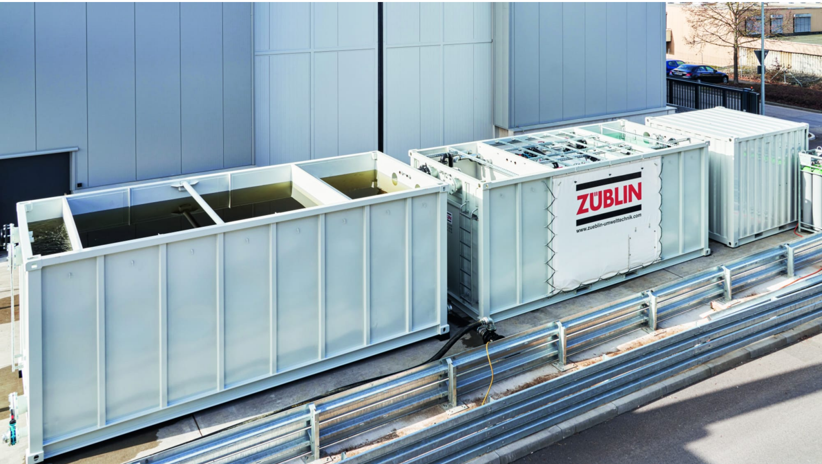
Alle drei Module auf einen Blick – Absetzbecken, BW-KOMPAKT und NEUTRA-KOMPAKT (Copyright: Ed. Züblin AG)
