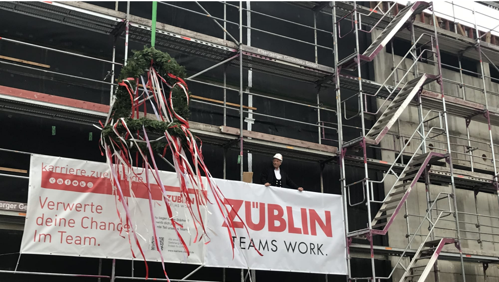
ZÜBLIN-Polier M. Helbig hielt den traditionellen Richtspruch (Copyright: Ed. Züblin AG)
